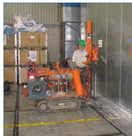
Abb.: Rammkernsondierung innerhalb eines Gebäudes
